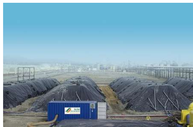
Proceso de descontaminación, técnica biopilas
