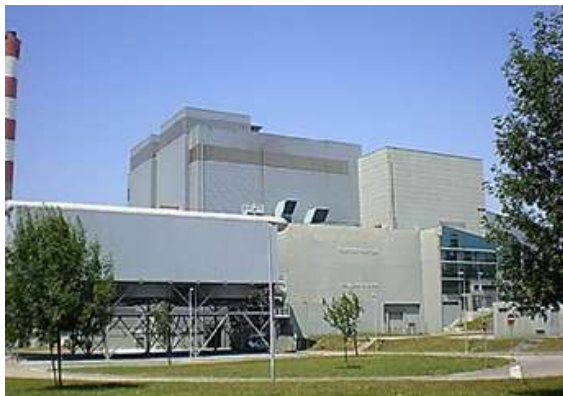
Planta Waste-to-Energy en Porto (Portugal)
