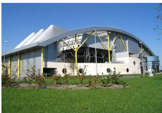
Planta Waste-to-Energy en Lille-Halluin (Francia)
