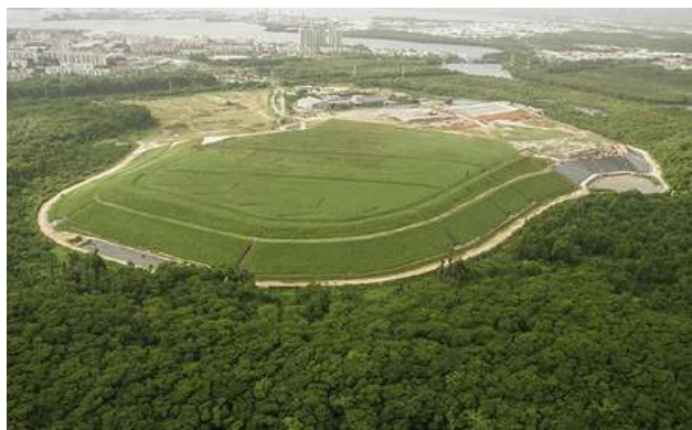
Vista aérea de sitio en proceso de descontaminación
