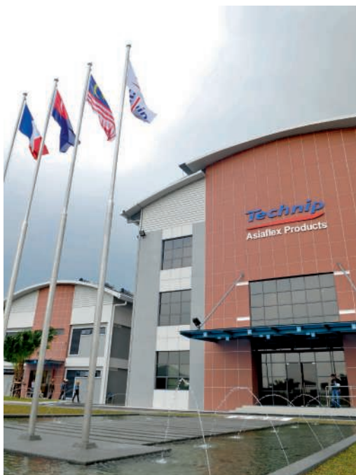
L'entrée de l'usine de conduites flexibles Asiaflex Products du groupe Technip dans la zone d'Iskandar.
